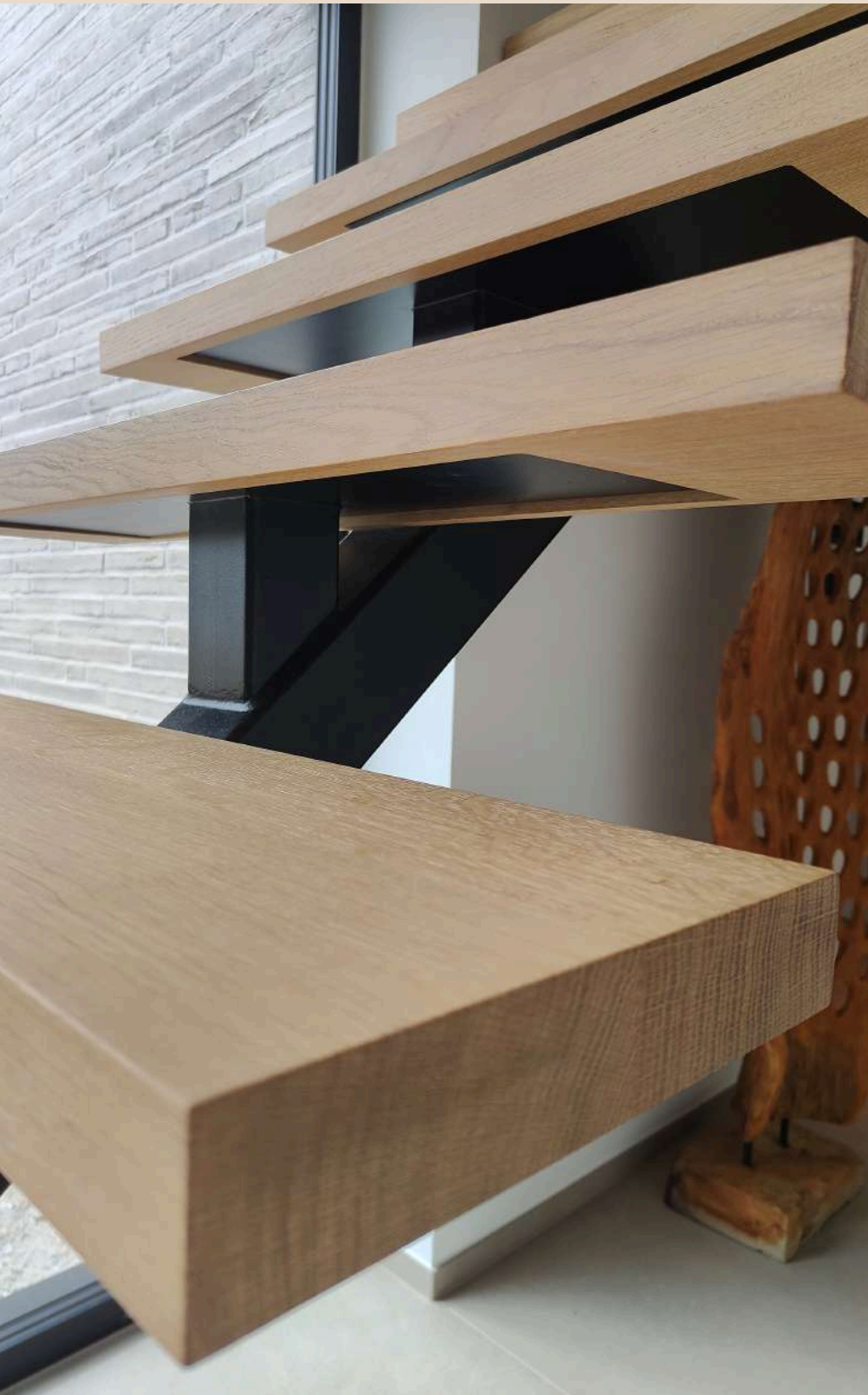
Marches en chêne massif avivé avec collage en micro-denture et traitement au Rubio Monocoat Vanilla sur structure métallique.
